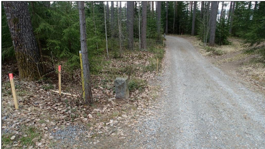
Kaapelilinja oli merkattu maastoon puupaaluilla. Kaijan- ja Aholantien risteysaluetta. Etelään.
